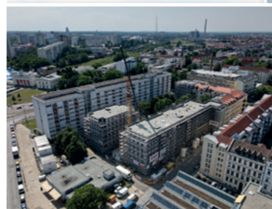
Bernhard-Göring-Straße Richtfest am 16. Juni 2020
