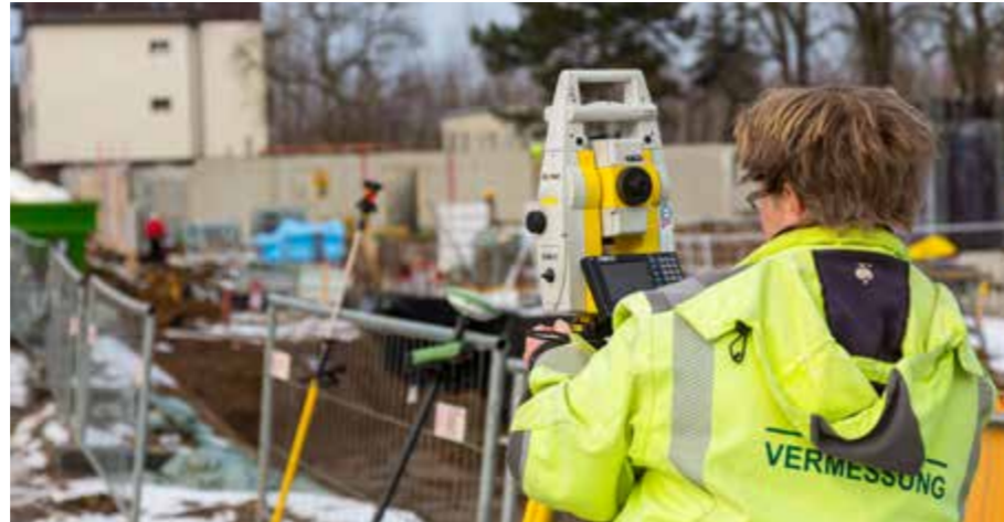
Die Arbeiten auf den LWB Baustellen wie oben an der Landsberger Straße gehen voran. Im März kam mit der Hafenstraße eine weitere Baustelle hinzu. Auch neue Sanierungsprojekte wurden gestartet.
