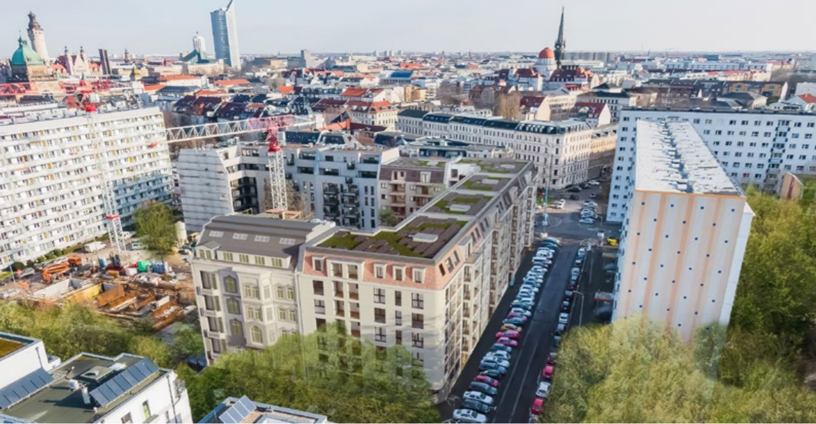
Im Sommer geht es mit den Ausschreibungen für den Neubau an der Robert-Schumann-Straße, nicht weit vom Hauptbahnhof, los.
