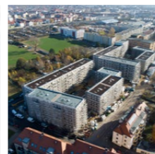
Im Bau: Saalfelder Straße
