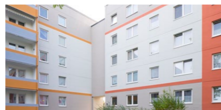
Fertigstellung: Ende 2022 Poserstraße 57-87 Fassadensanierung und Balkonanbau
