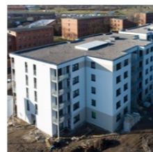
Im Bau: Landsberger Straße
