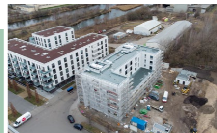
Im Bau: Hafensstraße
