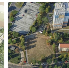
In Vorbereitung: Mockauer Straße
