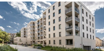
Fertiges Projekt: Bernhard-Göring-Straße
