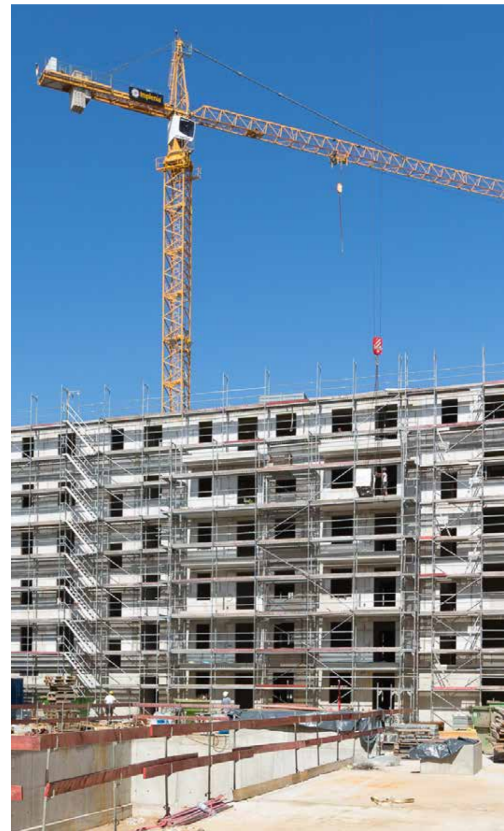
Die LWB baut derzeit an mehreren Standorten. Dafür gibt es einen Masterplan.
