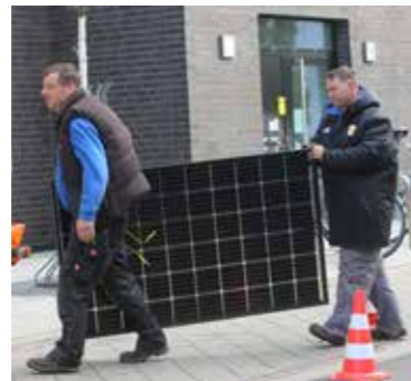
In der Hafensstraße wurden die Solarplatten an allen 18 Balkonen der LWB Wohnungen montiert.
